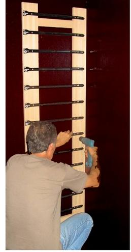
Schraube nun die 4 Anlegeleitern mit den Schrauben 4,2x38 an die Wände, die kleine Leiter unter die Klimaanlage.
