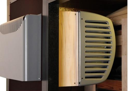
Schieben Sie das Ganze von innen in die Öffnung und stützen Sie sich dabei auf die Silentblöcke. Befestigen Sie sie mit den TH-Schrauben und breiten Unterscheiben.
