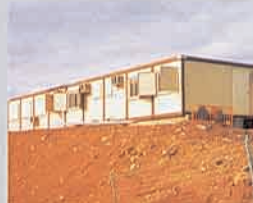
Casetas de obra
