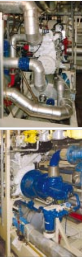
Gaswärmepumpenanlage im „Panoramabad“ Freudenstadt
