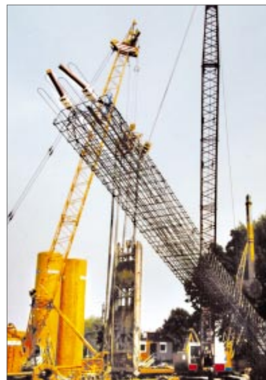
Gründungspfahl als Erdwärmesonde
